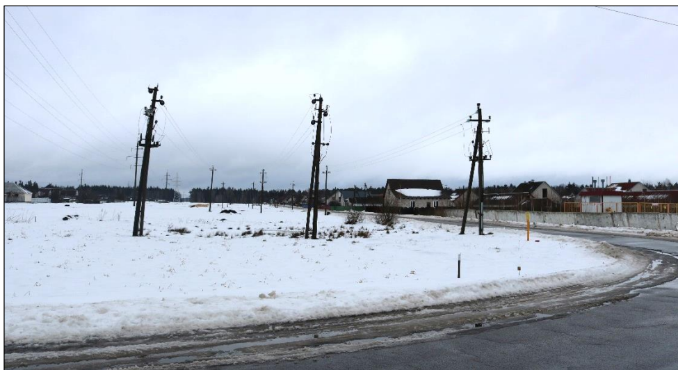
Рисунок 3.6 – Залежная растительность вдоль ЛЭП на северо-восточной окраине г.п. Лельчицы
